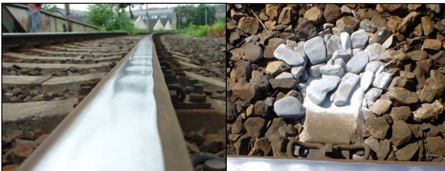
Obr. 6 Vlnkovitost a poklesy pražců
