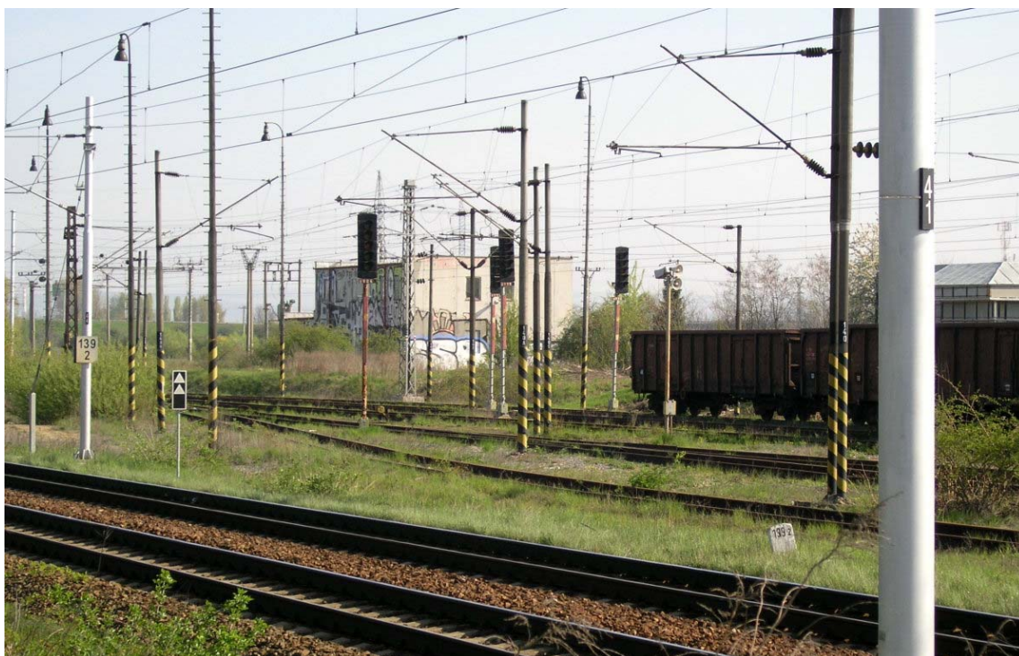
Obrázek 3: Výhybna Brno-jih: deponované nákladní vozy na pozadí chátrající budovy ústředního stavědla
