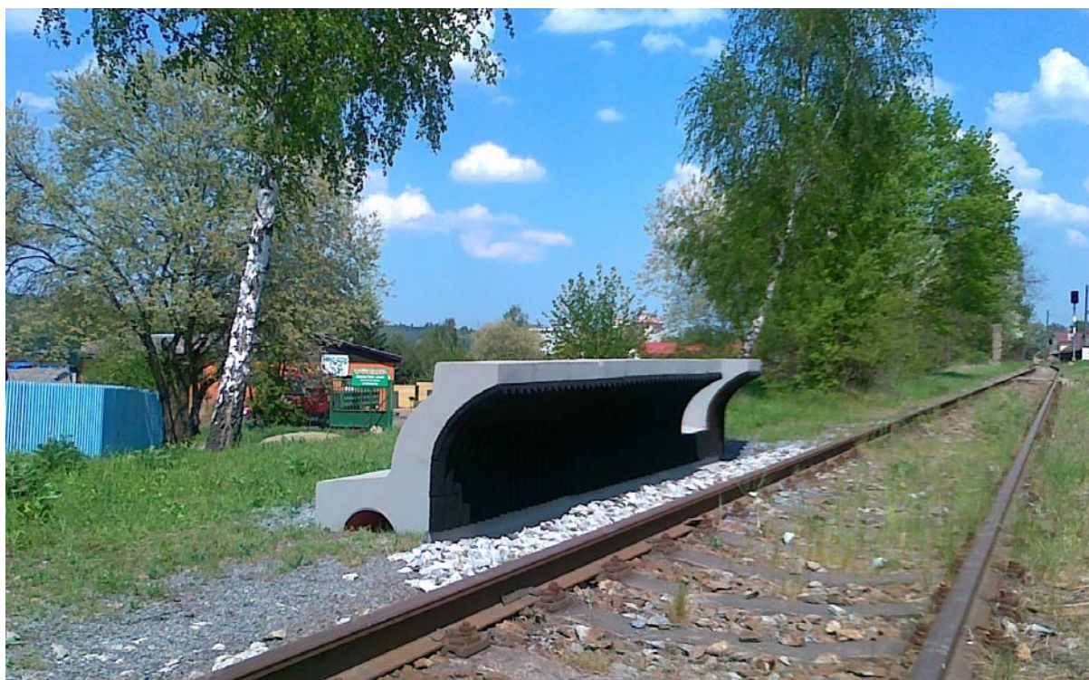
Foto č. 2 a 3 – Prototyp nízké protihlukové clony na vlečce ŽPSV v Čerčanech - – leden a květen 2012
