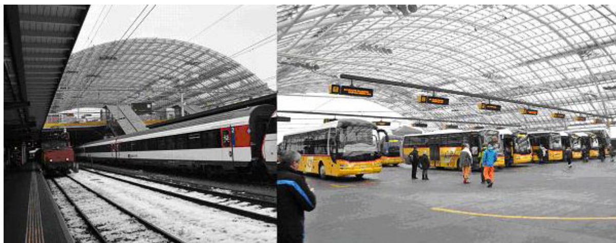
Obr. č. 5 - Vertikální přestup na autobusy ve stanici Chur (Švýcarsko). Autobusové nádraží se nachází přímo nad nástupišti železniční stanice.
