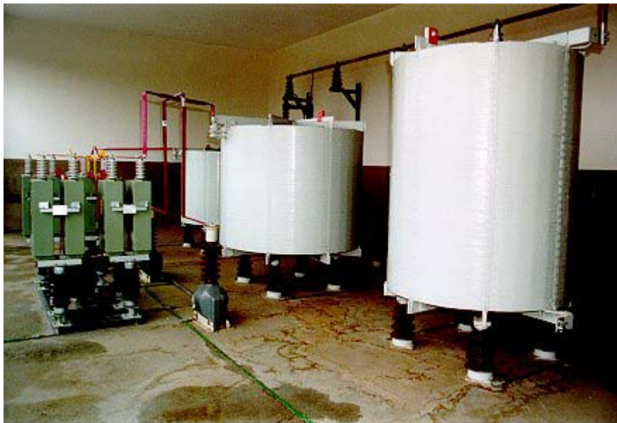
Filtračně kompenzační zařízení v TT Svitavy
