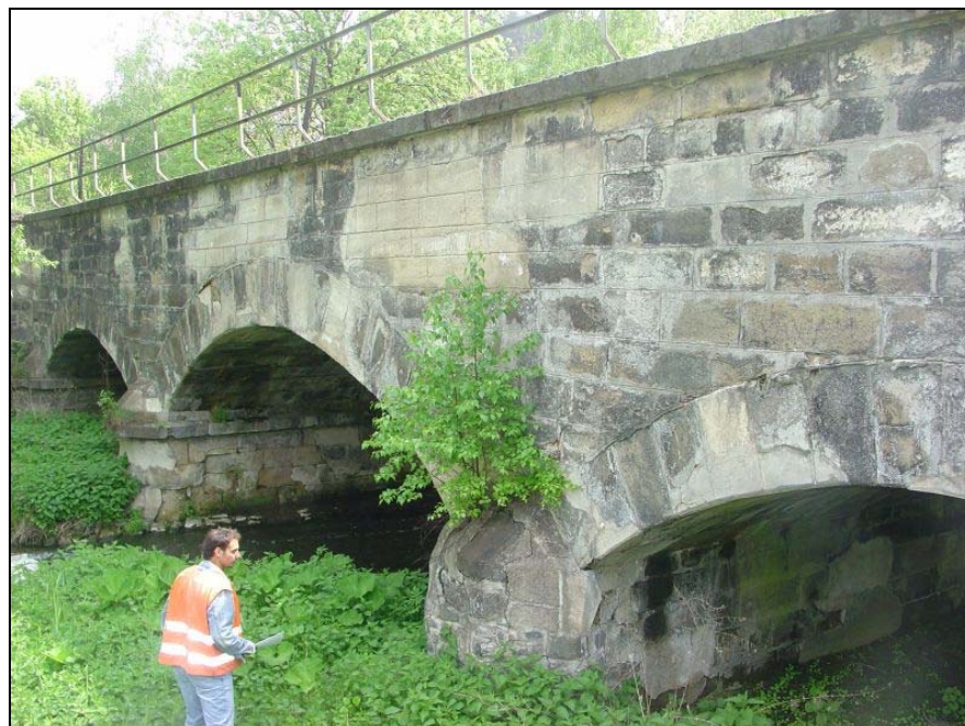
Obr. 1: Prohlídka mostního objektu
