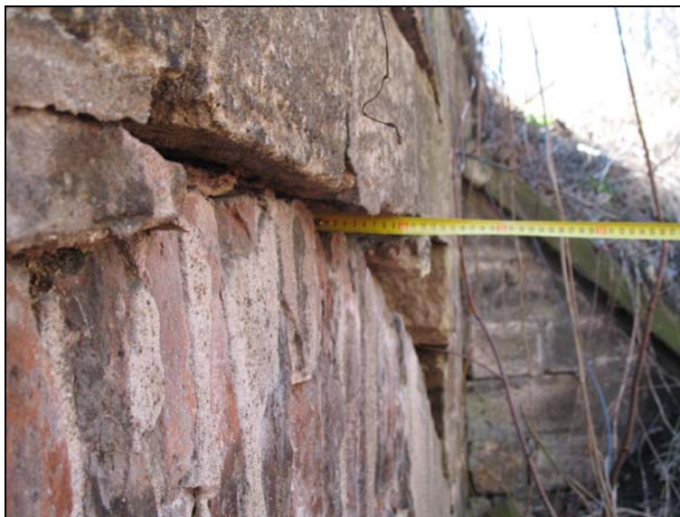
Obr. 6: Boulení čelní stěny
