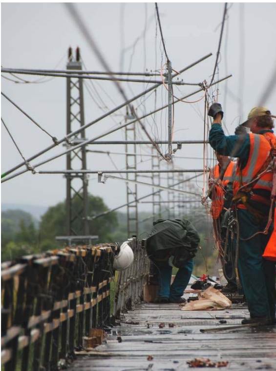
Obr. 4 Montáž trakčního vedení na VZO
