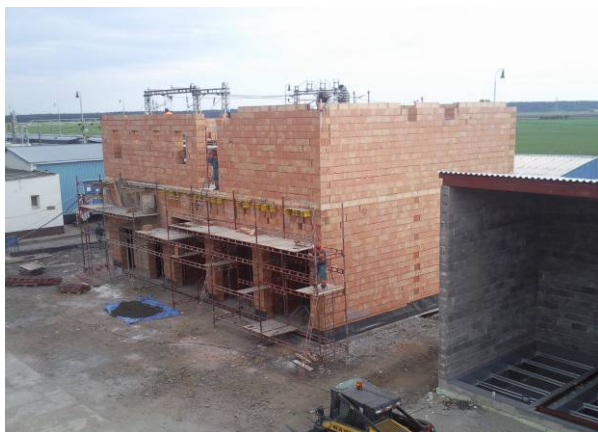
Obr. 2 Stavba nové měírny
