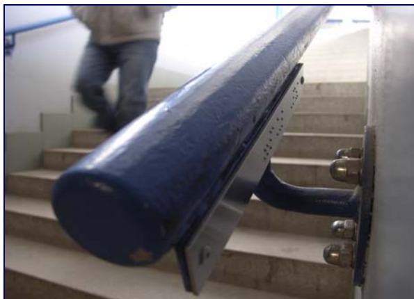
Obr. 3 Vzhled a umístění hmatného štítku na madle schodiště
