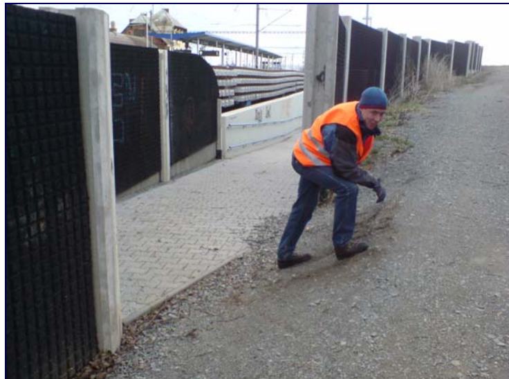
Obr. 16 Některé stanice jsou vinou nedořešených detailů napojení přístupových komunikací naprosto nepoužitelné pro cestující na vozíku nebo s dětským kočárkem
