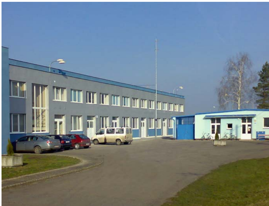
Obr. 6 - Základní budova Zkušebního centra
