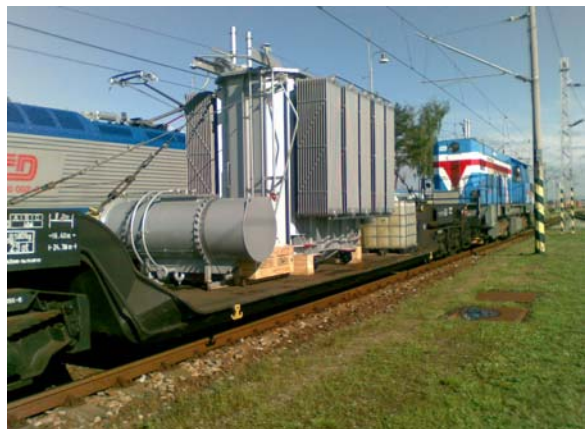
Obr. 3 Přeprava nového regulačního transformátoru
