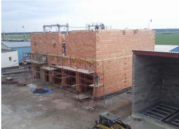
Obr. 2 Stavba nové měřiny
