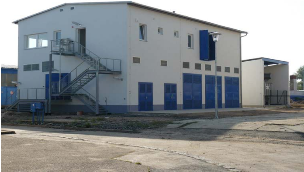
Obr. 8 Nová měnírna po dokončení
