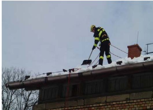
Obrázek č. 16 – Odstraňování sněhu s jištěním pomocí prostředků lezecké techniky
