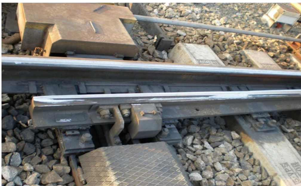
Obr. 6 - Jazyk výhybky po broušení
