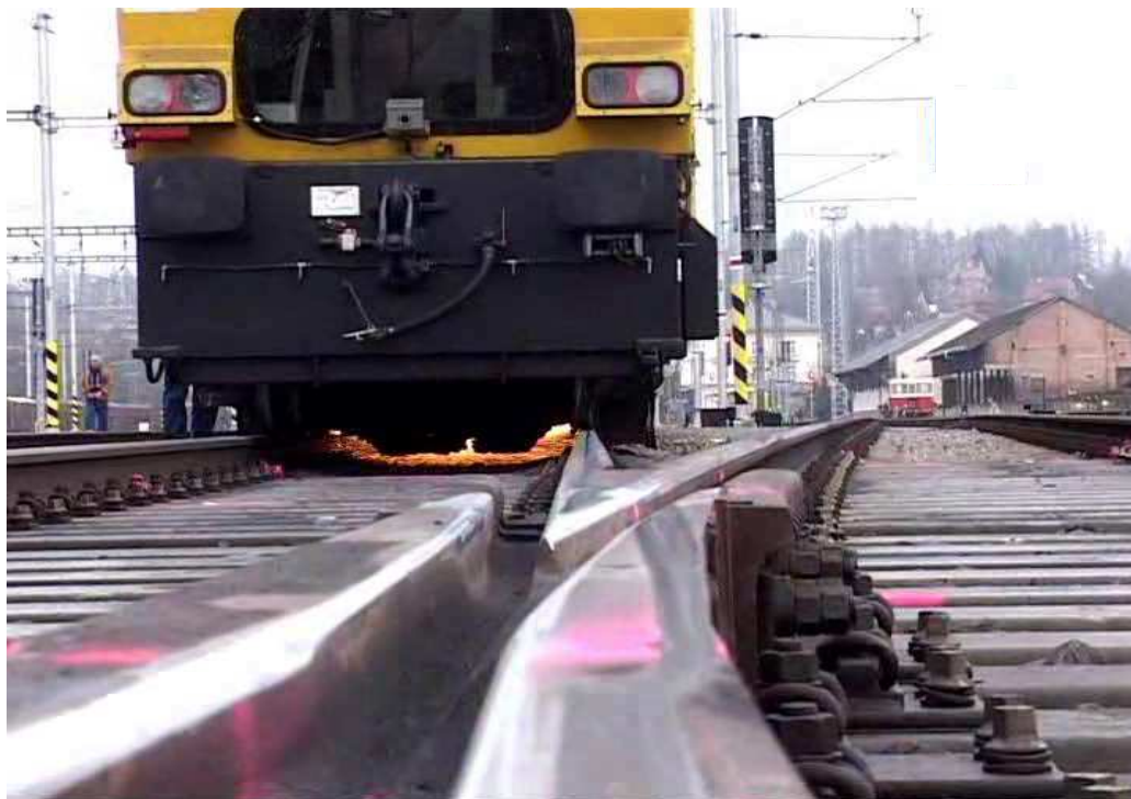
Obr. 1 - Broušení velkým traťovým strojem
