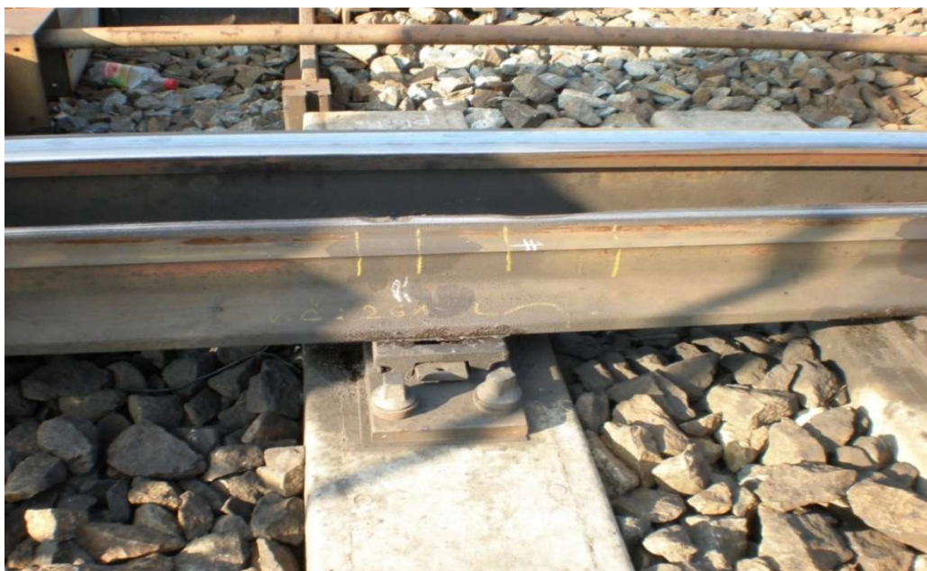
Obr. 5 - Jazyk výhybky před broušením
