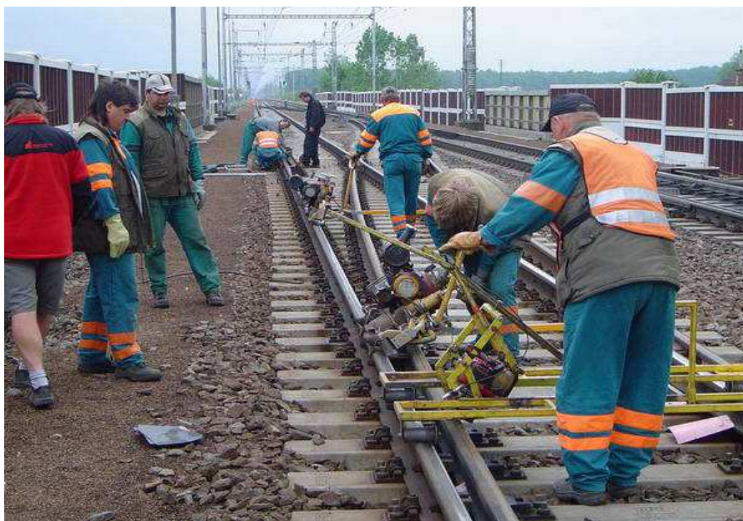
Obr. 2 - Broušení ručními bruskami
