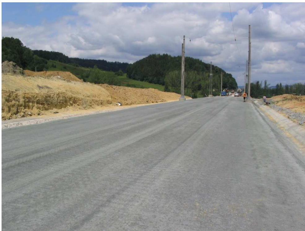
Obrázek 5 – Konstrukční vrstva z minerální směsi na dvoukolejné trati
